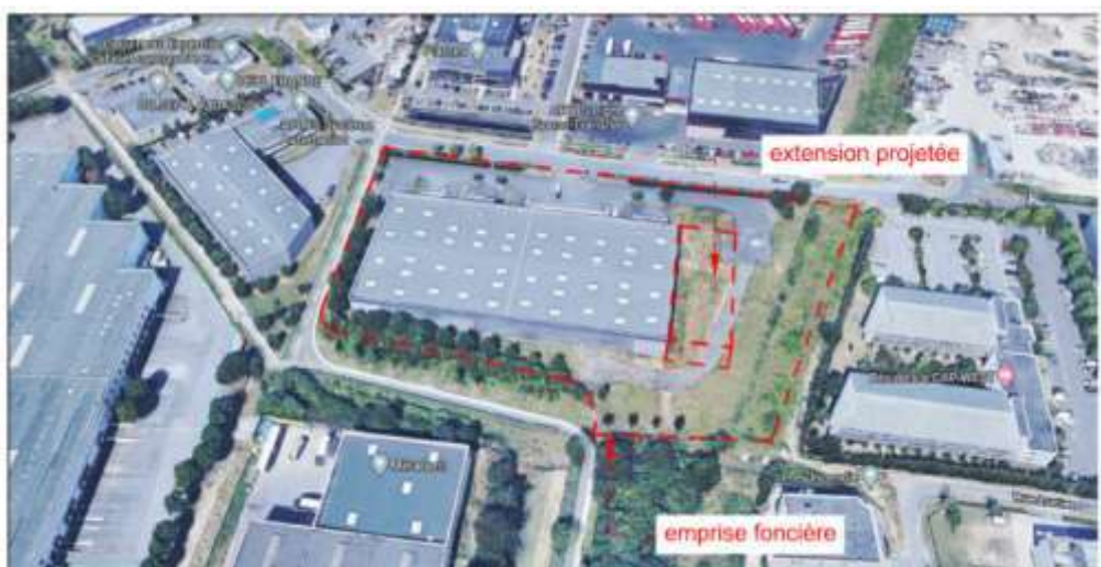
Vue aérienne depuis l'est
